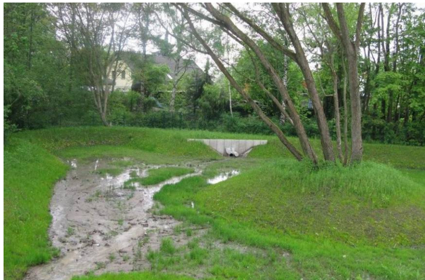
Regenrückhaltebecken Panketal, Bernauer Straße (Foto: Stephani-Pessel)
